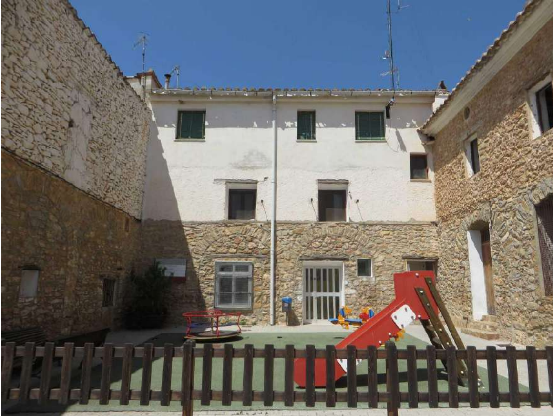
Ilustración 2. Fachada del colegio San Vicente de Piedrahita. Fuente: Sede del Catastro.
